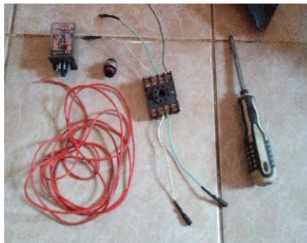
Gambar 7. Pemasangan Kabel pada Relay
